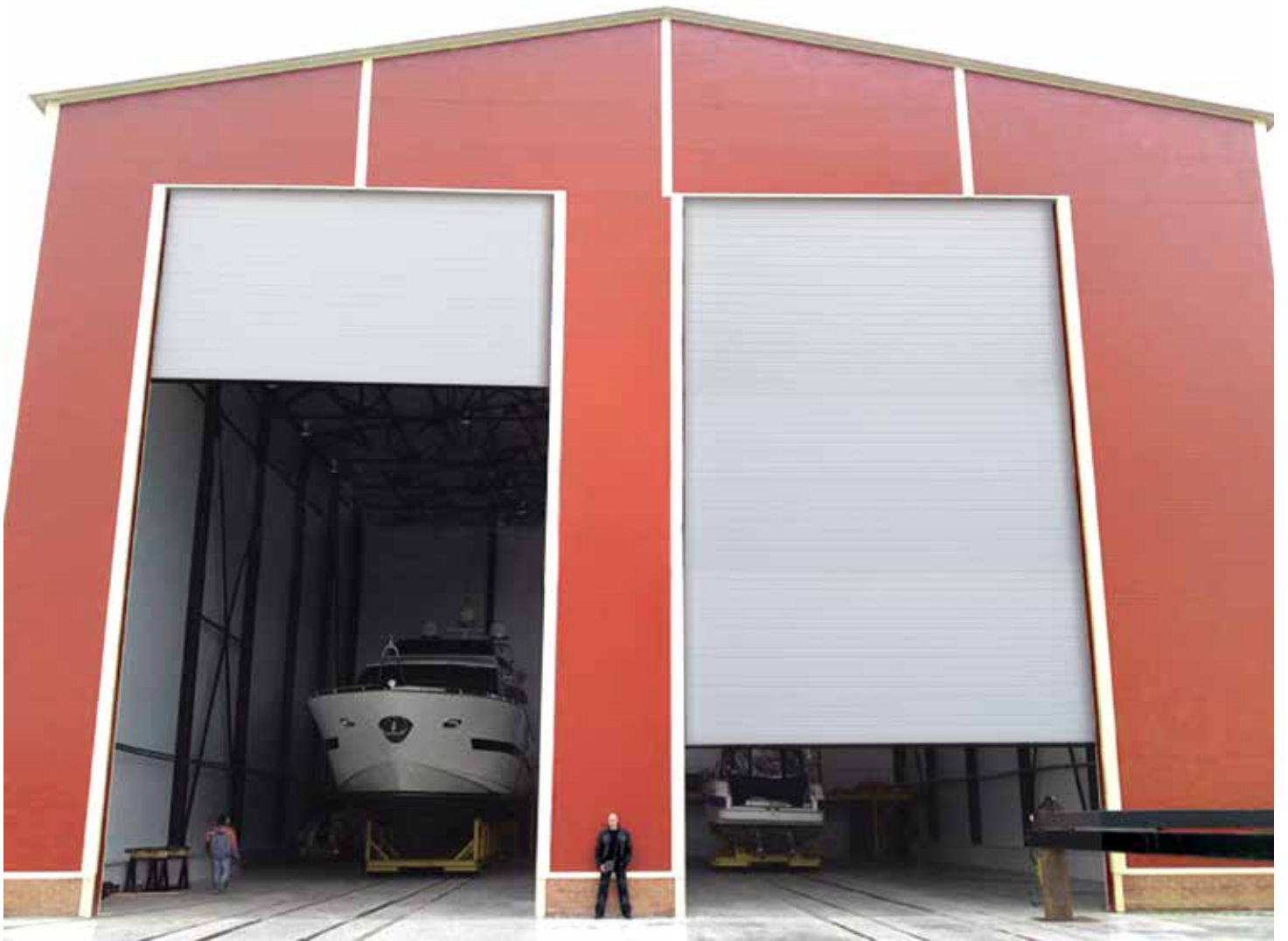
Porte Jumbo con motore diretto
